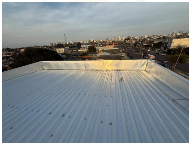
Figura 10: Detalhe da platibanda totalmente revestida
