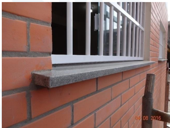
Figura 14: Detalhe da pingadeira de proteção nas laterais do vão
