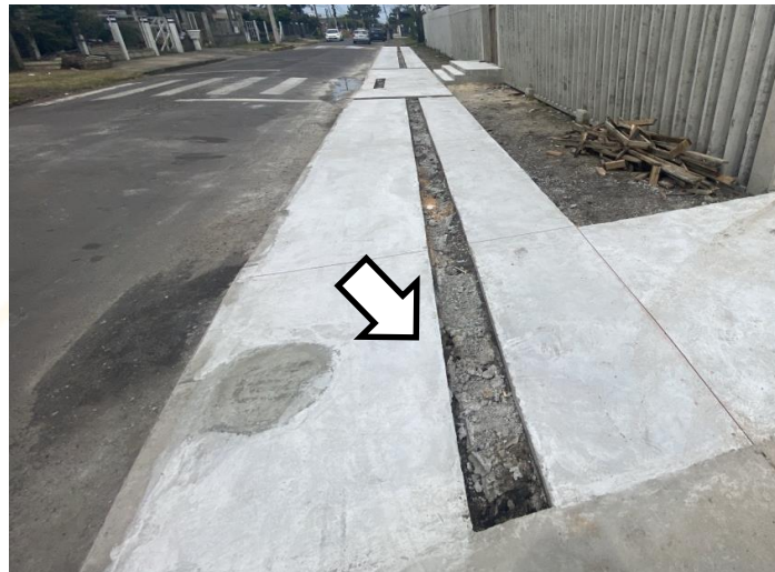
Figura 06: Detalhe modelo do passeio de concreto polido com gabarito na execução
