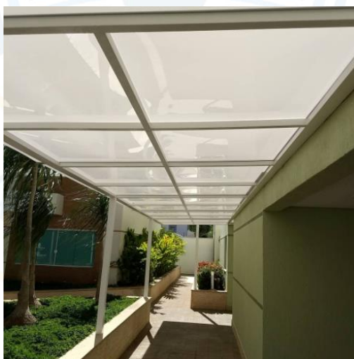
Figura 17: Detalhe do modelo de cobertura em alumínio e policarbonato
