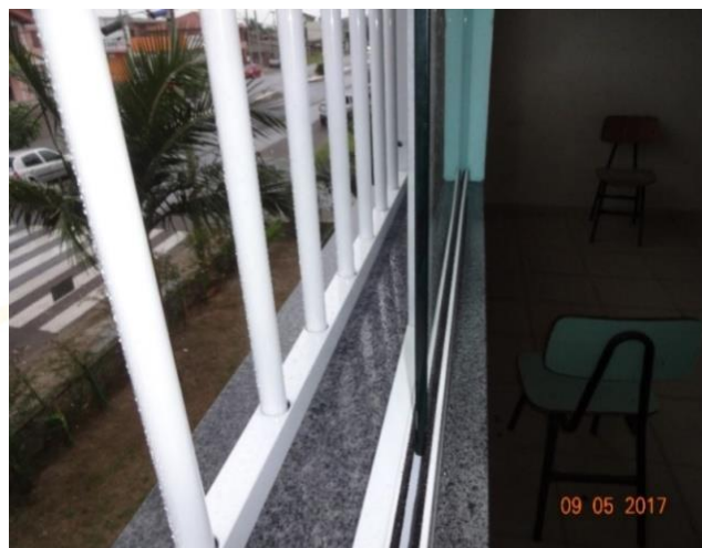
Figura 12: Modelo de janela, grade em alumínio e das pingadeiras
