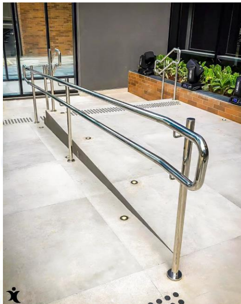
Figura 08: Modelo para instalação do corrimão em rampa
