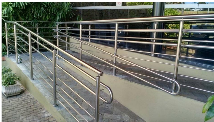
Figura 30: Modelo para instalação do corrimão (guarda corpo) em rampa
