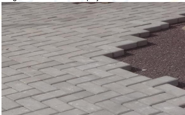
Figura 03: Modelo das peças de bloco intertravado
